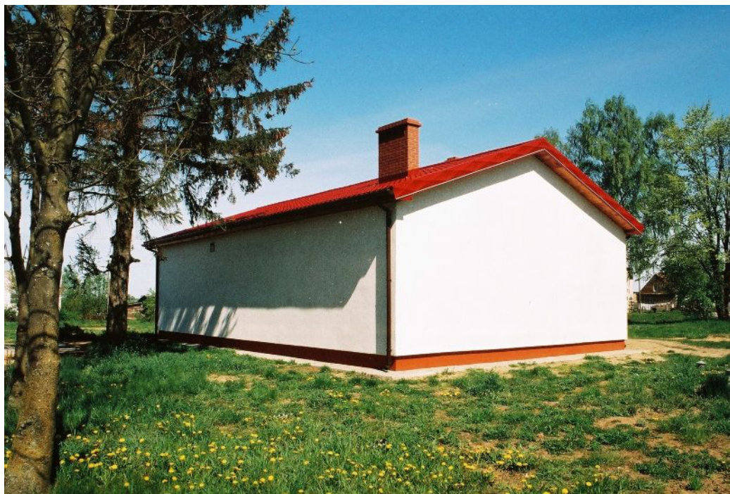
Fot. 30 Świetlica wiejska w miejscowości Gołębiewo
