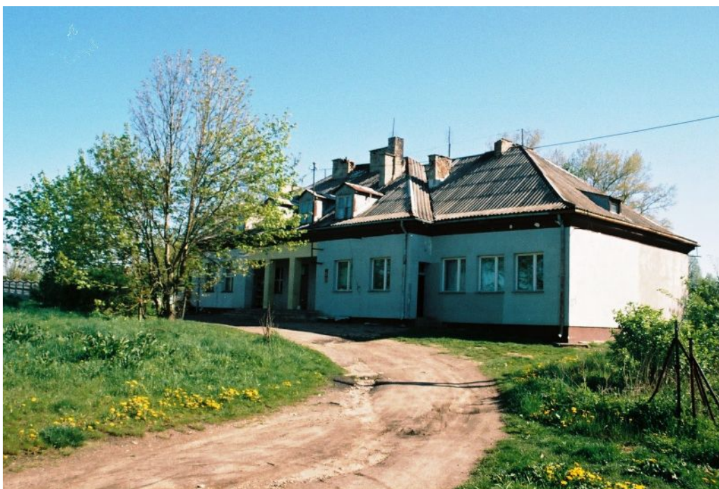
Fot. 24 Dawny budynek szkoły w miejscowości Niedanowo
