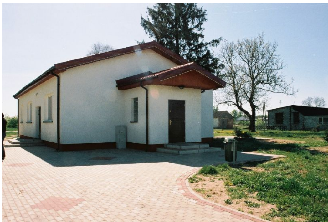
Fot. 29 Świetlica wiejska w miejscowości Gołębiewo
