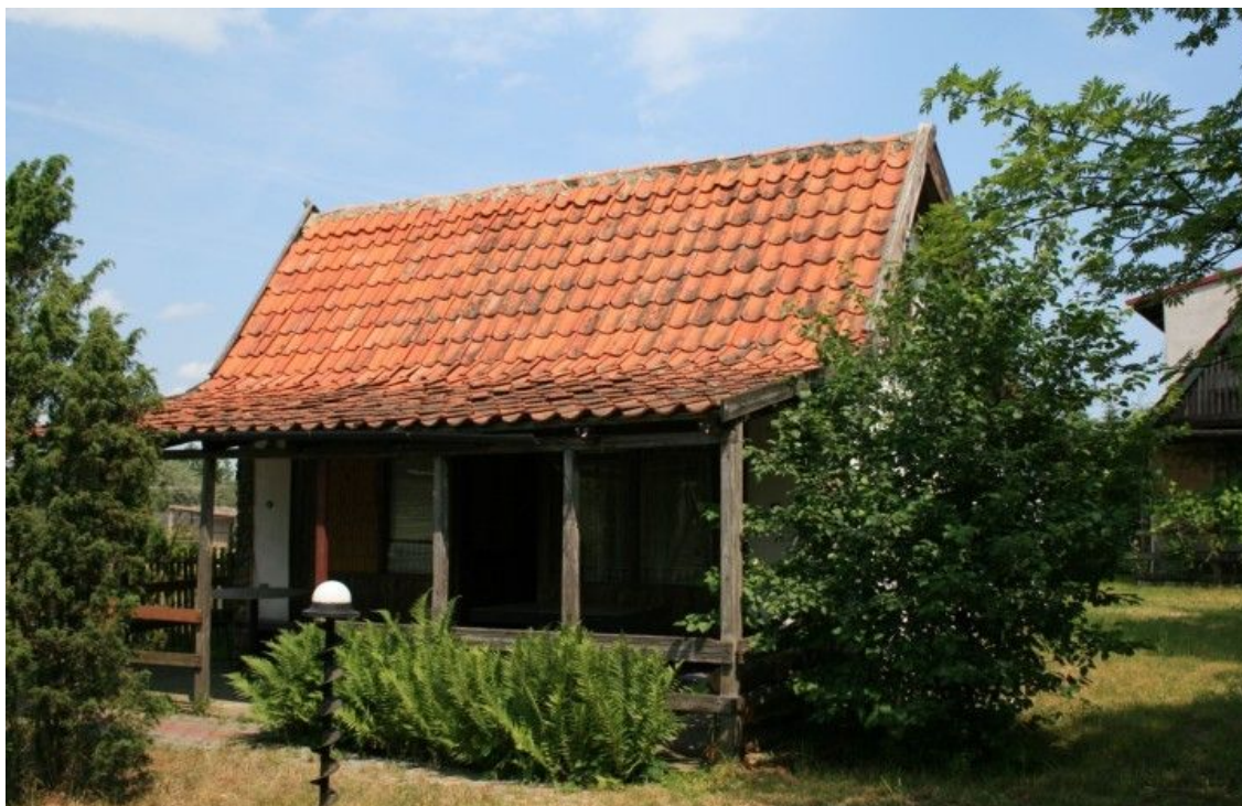
Fot. 20 Gospodarstwo agroturystyczne w miejscowości Szkotowo
