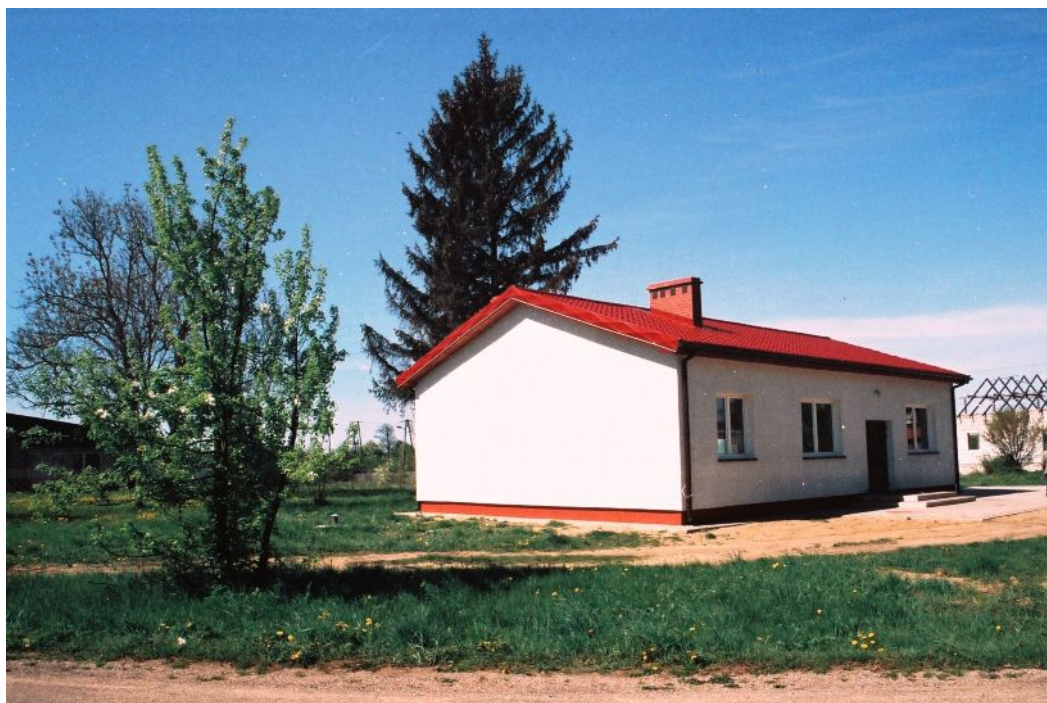
Fot. 31 Świetlica wiejska w miejscowości Gołębiewo
