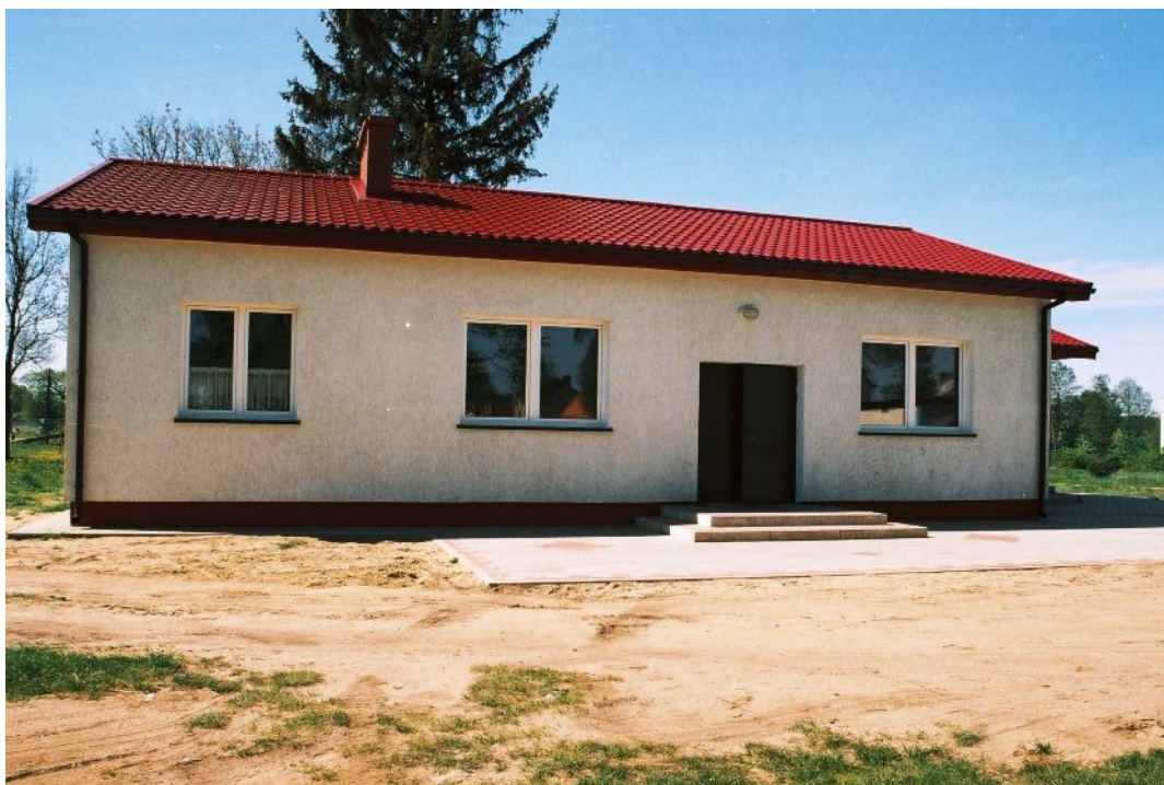
Fot. 28 Świetlica wiejska w miejscowości Gołębiewo
